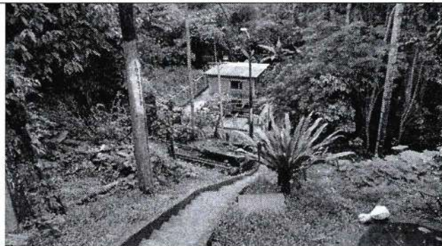
Foto 21. 13/11/19. Entrada a la PTAR, Nuevo Horizonte. No presenta una valla de identificación de la PTAR.
