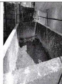
Foto 4. 12/11/19. Lechos de secado de lodos. Sin caracterización de los lodos y disposición final de los mismos.
